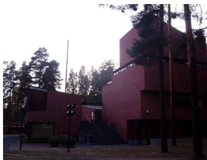
Ayuntamiento de Säynätsalo, obra de Alvar Aalto (foto de Xènia)
