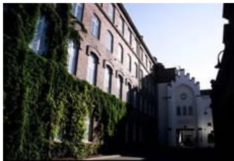
Antigua fábrica Finlayson, reconvertida en oficinas de varias empresas
