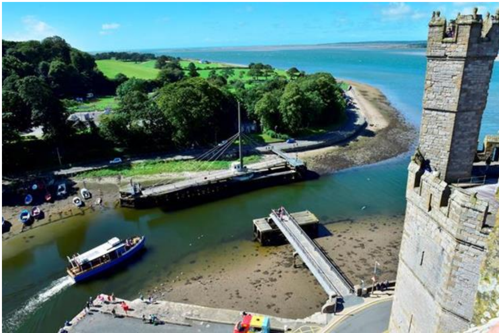
(Puente abierto para dar paso a una embarcación)
